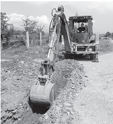
Подготовка траншей для укладки труб
